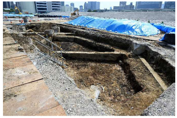
PI.20 ③区 1.5m掘削状況(西から)
