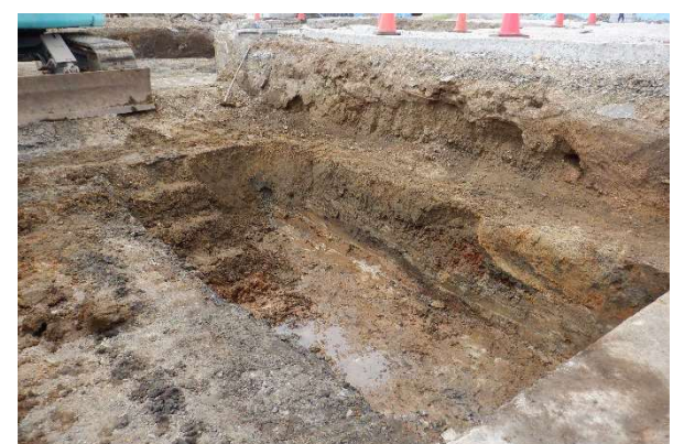
PI.34 ⑧区・2m掘削状況(北東から)
