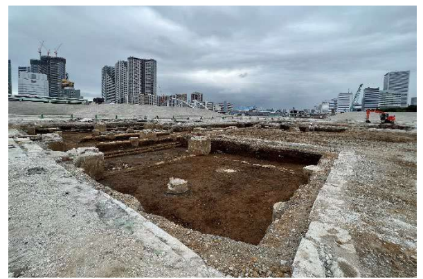
PI.30 ⑦-2区・1m掘削状況(南東から)
