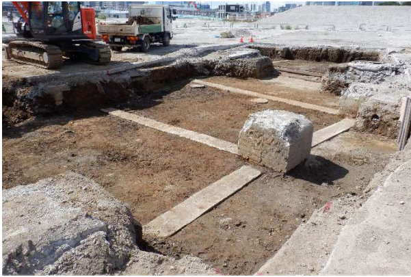
PI.27 ⑥区・1m掘削状況(北東から)
