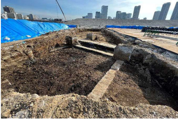
PI.19 ③区・1m掘削状況(東から)
