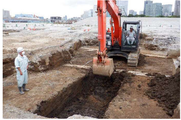
PI.28 ⑥区・2m掘削状況(東から)
