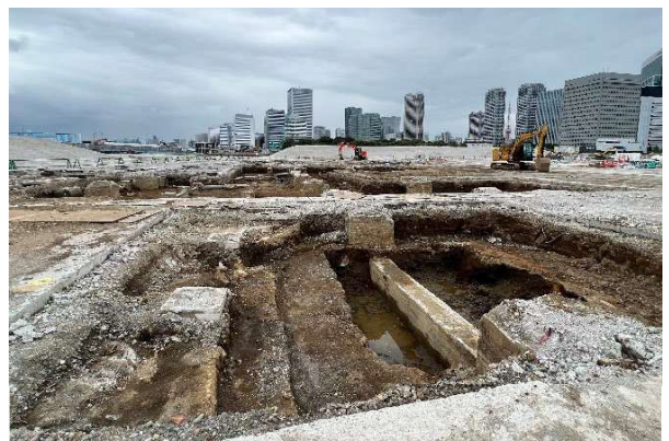
PI.32 ⑦-2区・2m掘削状況(東から)
